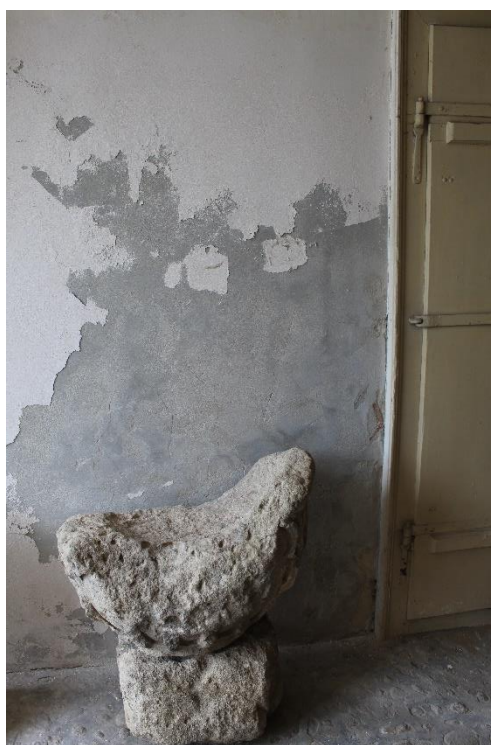
Gang. Efectele umidității capilare cauzate de tencuiala cu ciment.
