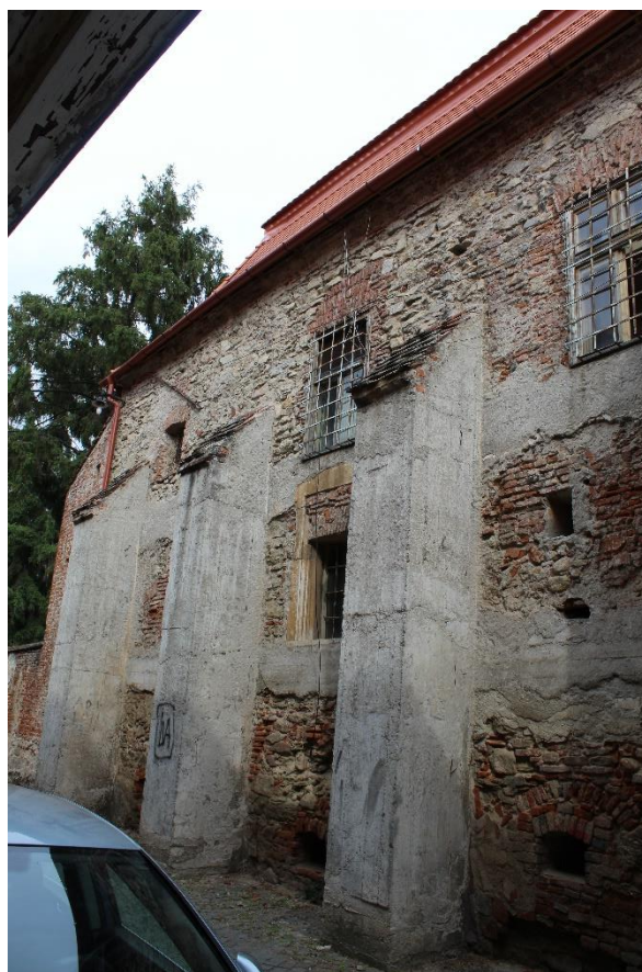
Fațada laterală vestică cu contraforții reconstruiți din beton.
