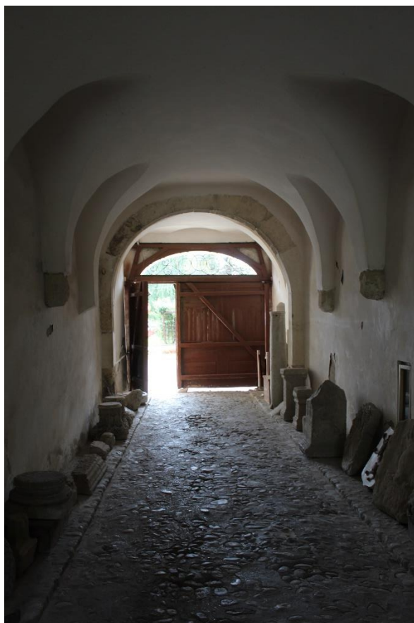
Gangul boltit cu console de piatră.
