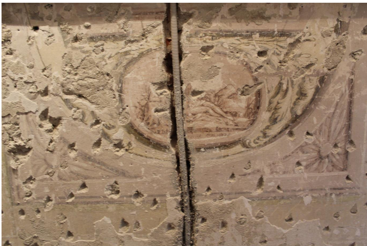
Etaj, sala sud-vestică. Peretele nordic. Suprafață lăsată aparent cu pictură murală. Deteriorările vizibile: martelări, introducere de cabluri .
